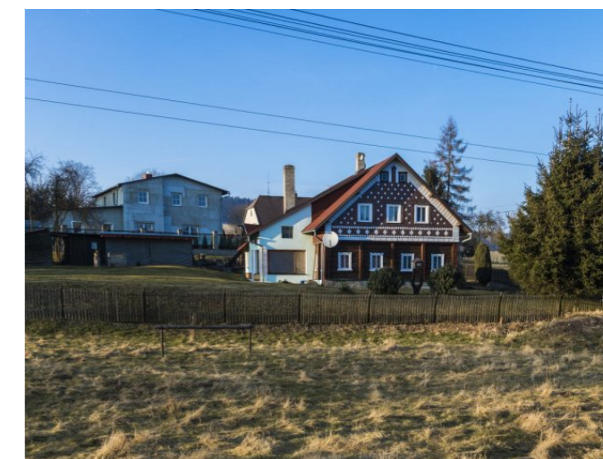
Staré Křečany č. ev. 35 - Pohled na objekt (Zdroj: S. Šulcová, 2018)
