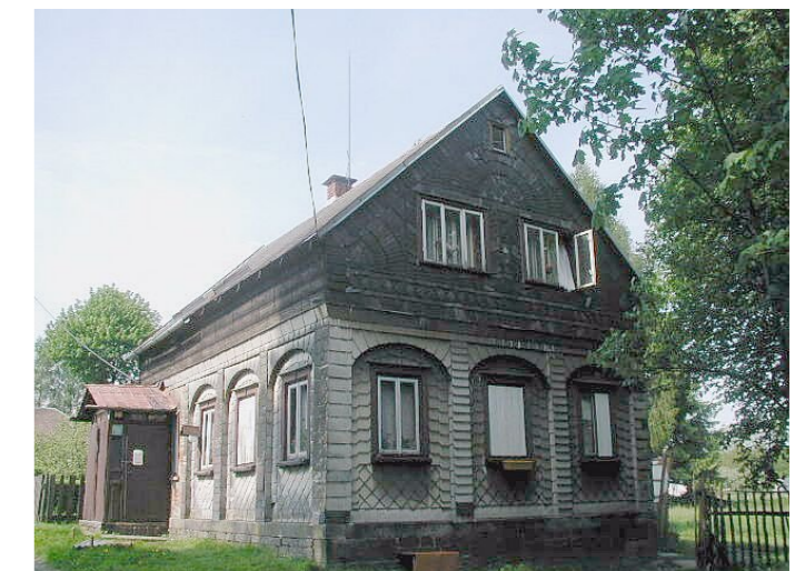
Staré Křečany č. p. 503 - Pohled na objekt (Zdroj: TUR Šluknovsko, 2003)
