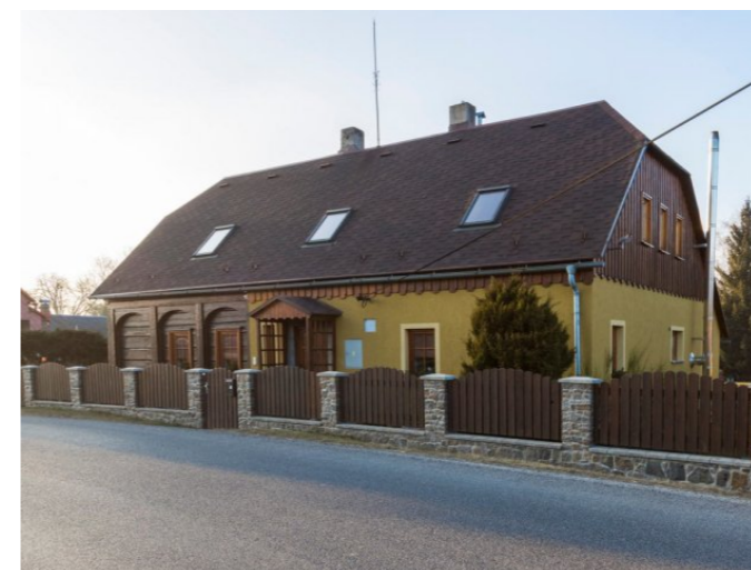
Staré Křečany č. p. 462 - Pohled na objekt (Zdroj: S. Šulcová, 2018)
