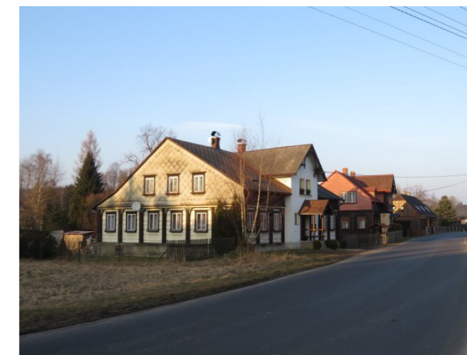
Staré Křečany č. p. 454 - Pohled na objekt (Zdroj: S. Šulcová, 2018)
