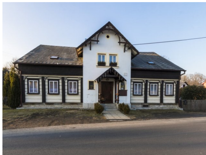
Staré Křečany č. p. 454 - Pohled na objekt (Zdroj: S. Šulcová, 2018)
