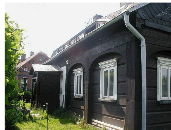
Staré Křečany č. p. 419 - Pohled na objekt (Zdroj: TUR Sluknovsko, 2003)
