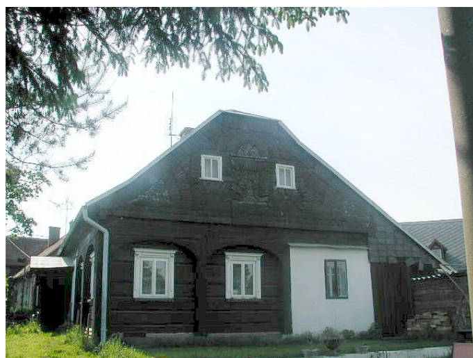
Staré Křečany č. p. 419 - Pohled na objekt (Zdroj: TUR Sluknovsko, 2003)
