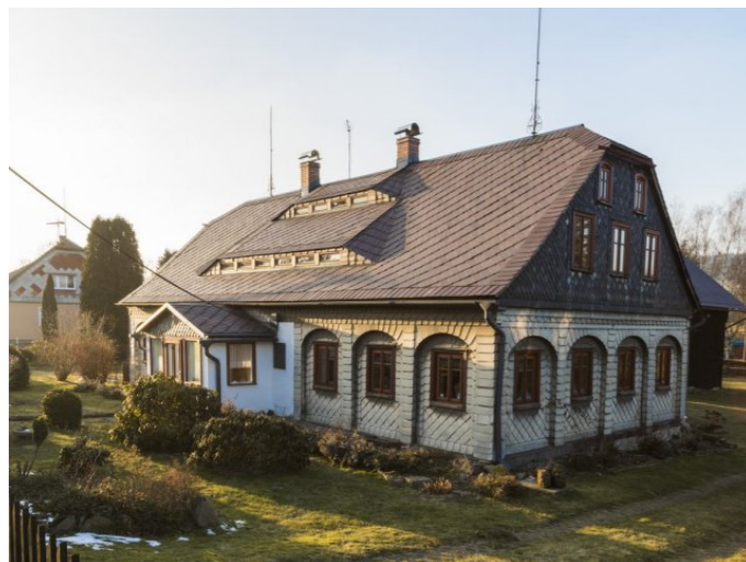
Staré Křečany č. p. 398 - Pohled na objekt (Zdroj: S. Šulcová, 2018)
