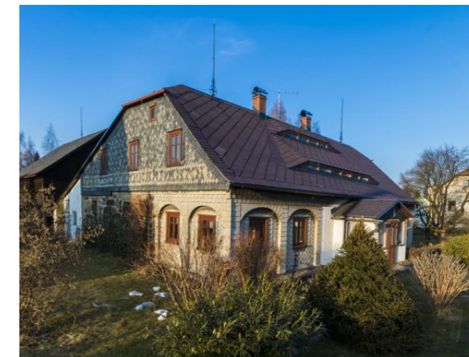
Staré Křečany č. p. 398 - Pohled na objekt (Zdroj: S. Šulcová, 2018)
