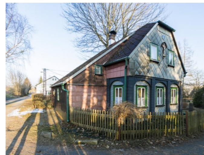
Staré Křečany č. p. 361 - Pohled na objekt (Zdroj: S. Šulcová, 2018)
