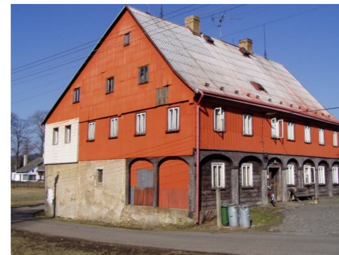
Staré Křečany č. p. 33 - Pohled na objekt (Zdroj: TUR Sluknovsko, 2003)
