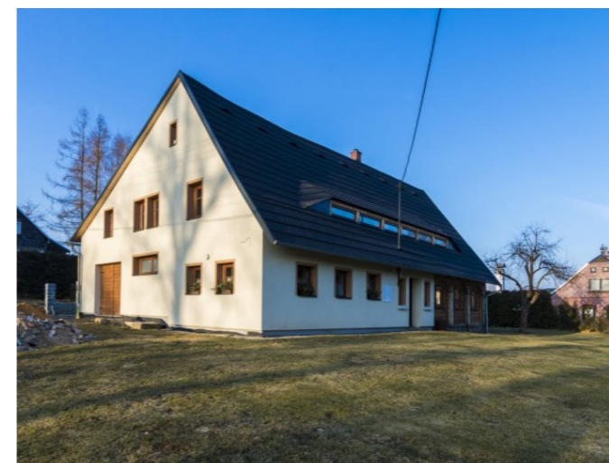
Staré Křečany č. p. 242 - Pohled na objekt (Zdroj: S. Šulcová, 2018)
