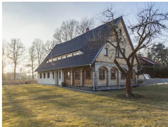
Staré Křečany č. p. 242 - Pohled na objekt (Zdroj: S. Šulcová, 2018)
