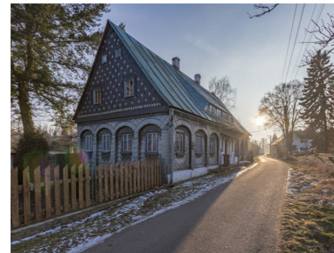
Staré Křečany č. p. 232 - Pohled na objekt (Zdroj: S. Šulcová, 2018)
