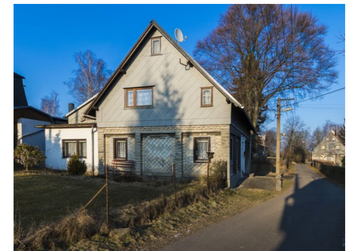
Staré Křečany č. p. 230 - Pohled na objekt (Zdroj: S. Šulcová, 2018)
