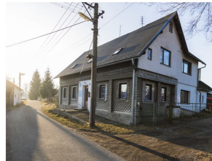
Staré Křečany č. p. 230 - Pohled na objekt (Zdroj: S. Šulcová, 2018)
