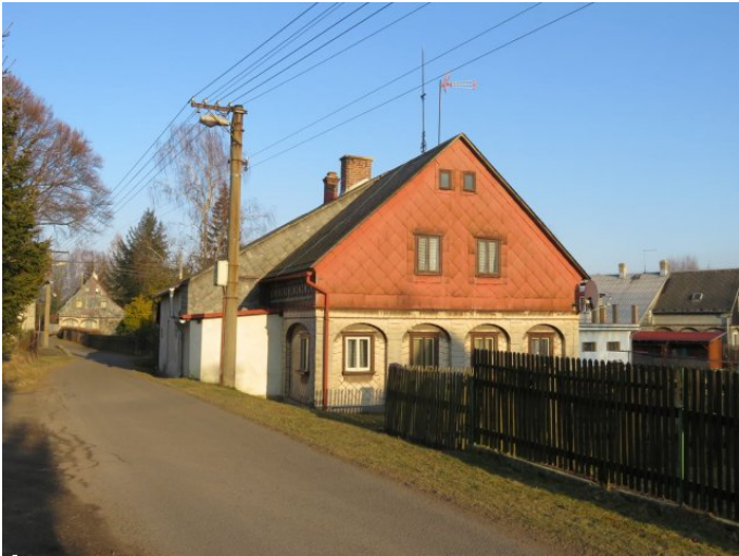
Staré Křečany č. p. 226 - Pohled na objekt (Zdroj: S. Šulcová, 2018)
