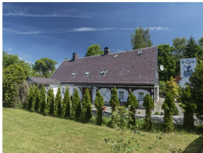
Mikulášovice č. p. 56 - Pohled na objekt z jihozápadu (Zdroj: S. Šulcová, 2017)
