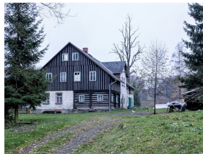
Mikulášovice č. p. 357 - Pohled na objekt ze severovýchodu (Zdroj: S. Šulcová, 2017)
