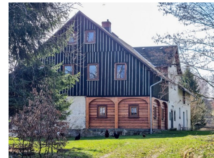
Mikulášovice č. p. 357 - Pohled na objekt ze severovýchodu (Zdroj: S. Šulcová, 2024)
