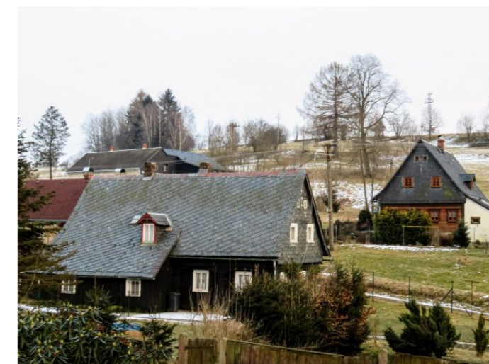
Brtníky č. p. 134 - Pohled na objekt ze severu (Zdroj: S. Šulcová, 2018)
