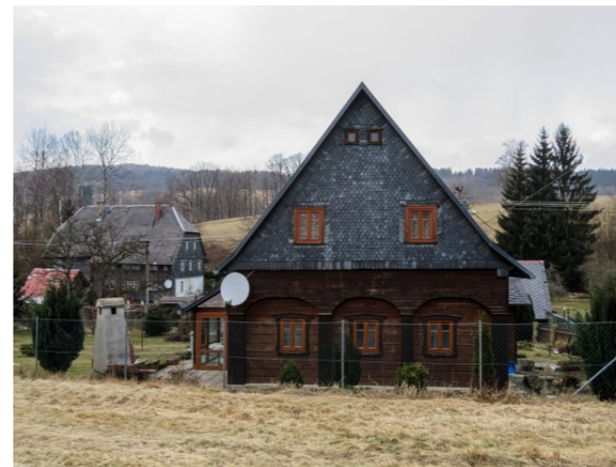
Brtníky č. p. 204 - Pohled na objekt z jihu (Zdroj: S. Šulcová, 2018)
