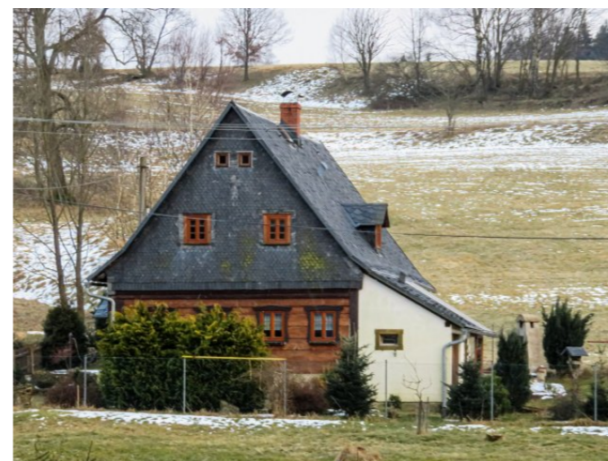
Brtníky č. p. 204 - Pohled na objekt ze severu (Zdroj: S. Šulcová, 2018)
